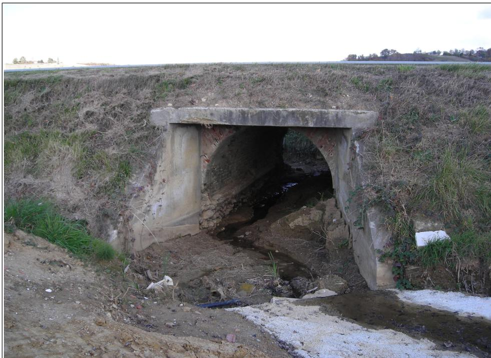
**Photo 8** : franchissement de la RD919 par le ruisseau de SOULEILLA ; on notera les traces de sédimentation sous l'ouvrage.
