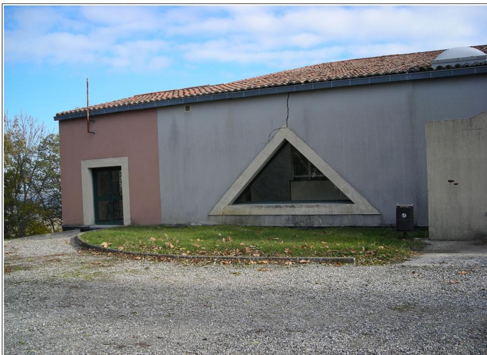
**Photo 11** : l'extrémité nord du gymnase de CARLA-BAYLE s'appuie dans le talus amont de la RD14, elle-même tracée à l'amont d'une zone de glissement de terrain actif (combe de LEGAY). On notera l'importante fissure visible au sommet de l'ouverture de section triangulaire.
